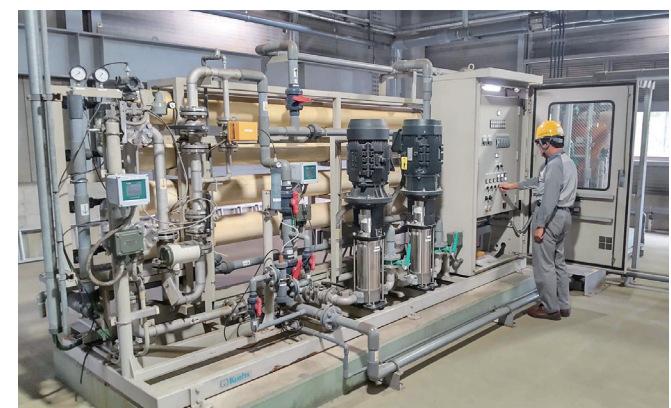
逆浸透膜(RO膜)装置
